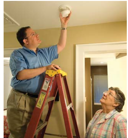
Instale detectores de humo y de monóxido de carbono en toda la casa y no olvidar el sótano.
