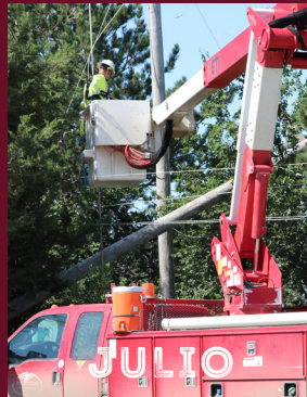
Los linieros reemplazan un poste dañado después de una tormenta.
